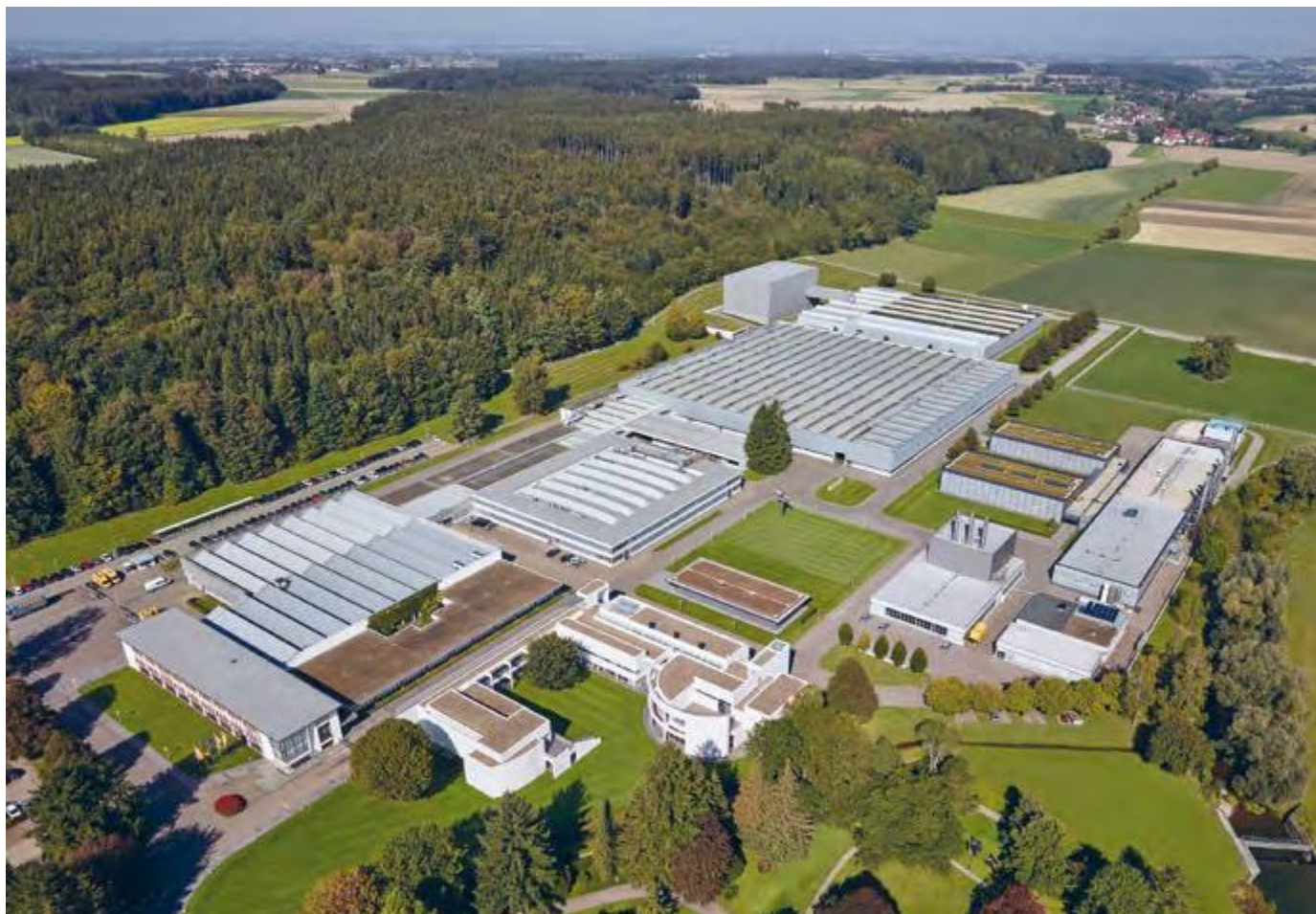
Завод Weishaupt, г. Швенди, Германия
